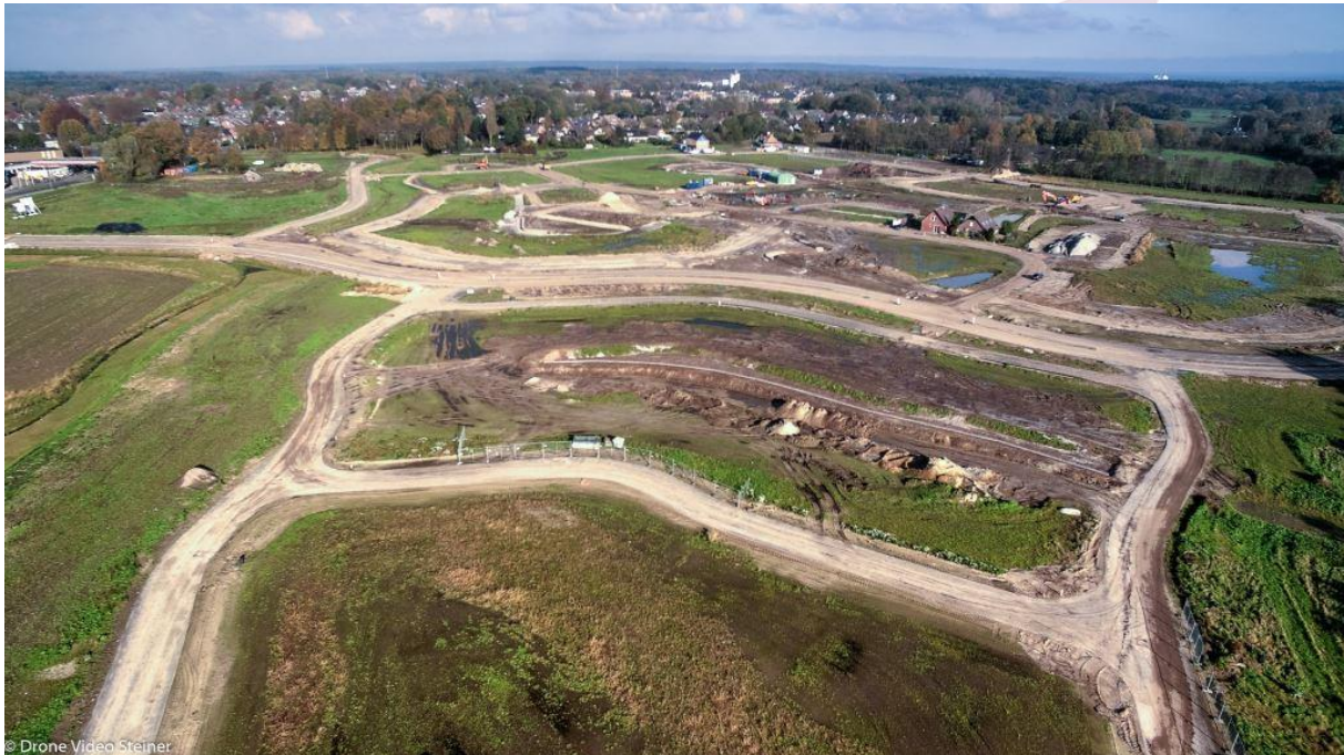
Een luchtfoto van november 2017, genomen in noordelijke richting. Aan de bovenzijde van de foto ligt de Wikselaarseweg. Foto: Drone Video Steiner.
